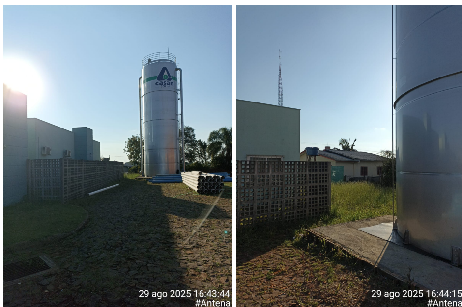
Figura 03: Local da instalação, bairro São Francisco
